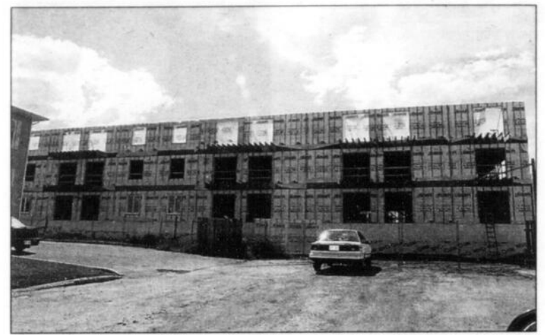
La construction de la Villa des Orchidées suscite la controverse auprès des citoyens de la rue Vincent. Ils estiment que leur tranquillité va disparaître.
