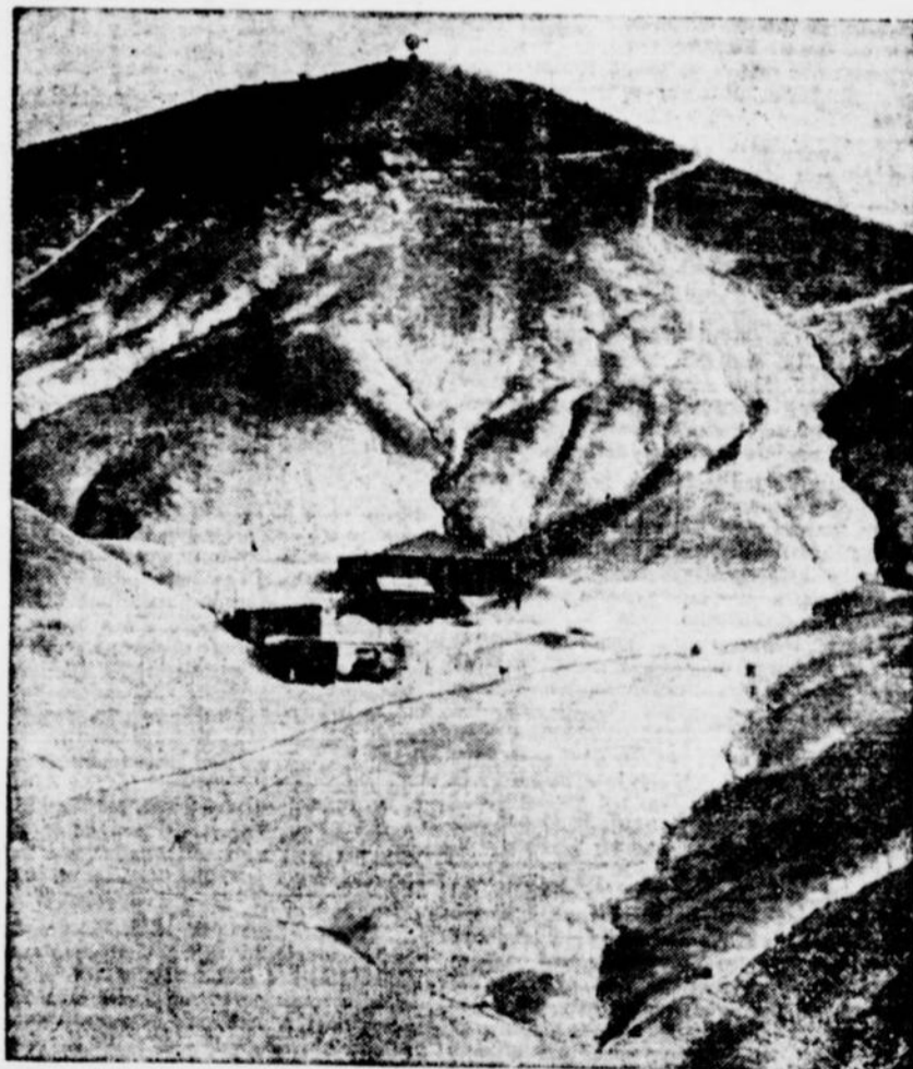
Station météorologique à Montezuma, dans les Andes, au Chili. Vignette du haut, à gauche, la station, vue de près
