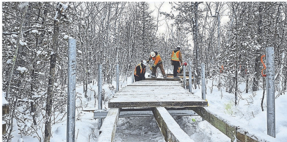
Des travaux de réhabilitation des sentiers sur pilotis ont été amorcés en 2024 et devraient être complétés d'ici quelques semaines. (Photo gracieuse - LAMRAC)
