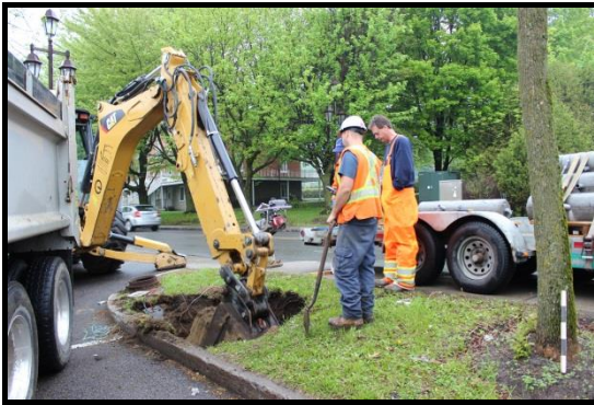
Photo 7 : Vue générale du sondage CfEt-7-13F en cours d'excavation, vers le nord-ouest (Photo : Manon Goyette, Ville de Québec).
