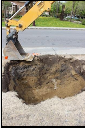
Photo 1 : Sondage CfEt-7-13A en fin d'excavation, vers l'ouest (Photo : Manon Goyette, Ville de Québec).
