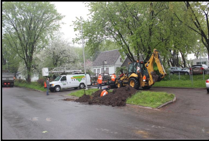
Photo 6 : Vue générale du sondage CfEt-7-13E en cours d'excavation, vers le nord-ouest (Photo : Manon Goyette, Ville de Québec).
