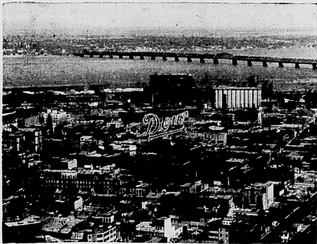
Photo de l'énorme enseigne Dow en néon dominant l'horizon de Montréal. Cette enseigne, la plus grosse du genre au monde, sera officiellement illuminée pour la première fois, le 25 juin dans la soirée. Elle est située sur le toit de l'usine Dow-Kingsbeer, rue Saint-Maurice, à Montréal.
