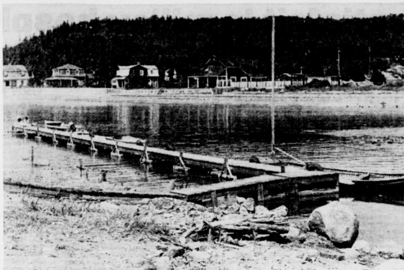
Les quais flottants sont dans le secteur du vieux quai.
