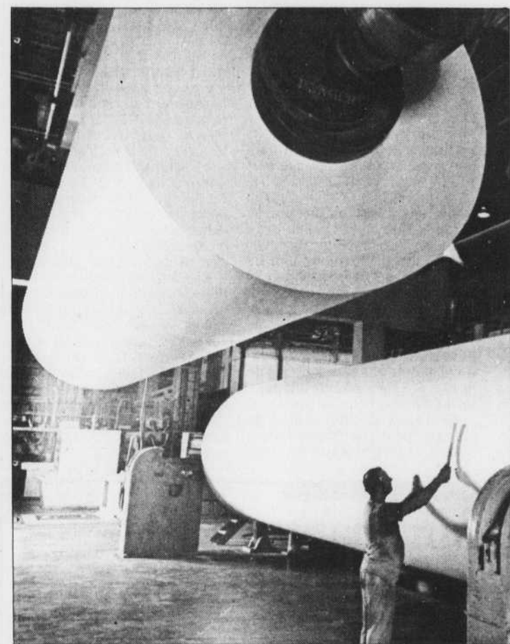
La nouvelle machine à déroulement rapide de Donohue aura une capacité annuelle de 180.000 tonnes métriques.
