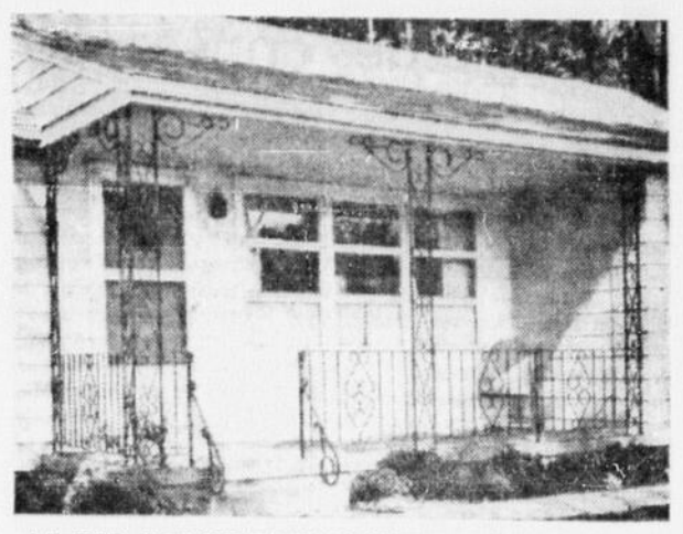
LE FER FORGE EMBELLIT à peu de frais la façade d'une résidence; l'illustration ci-dessus permet de constater que d'élegantes colonnes, balustrades et rampes ont été employées avec goût pour améliorer l'aspect extérieur de cette maison.
