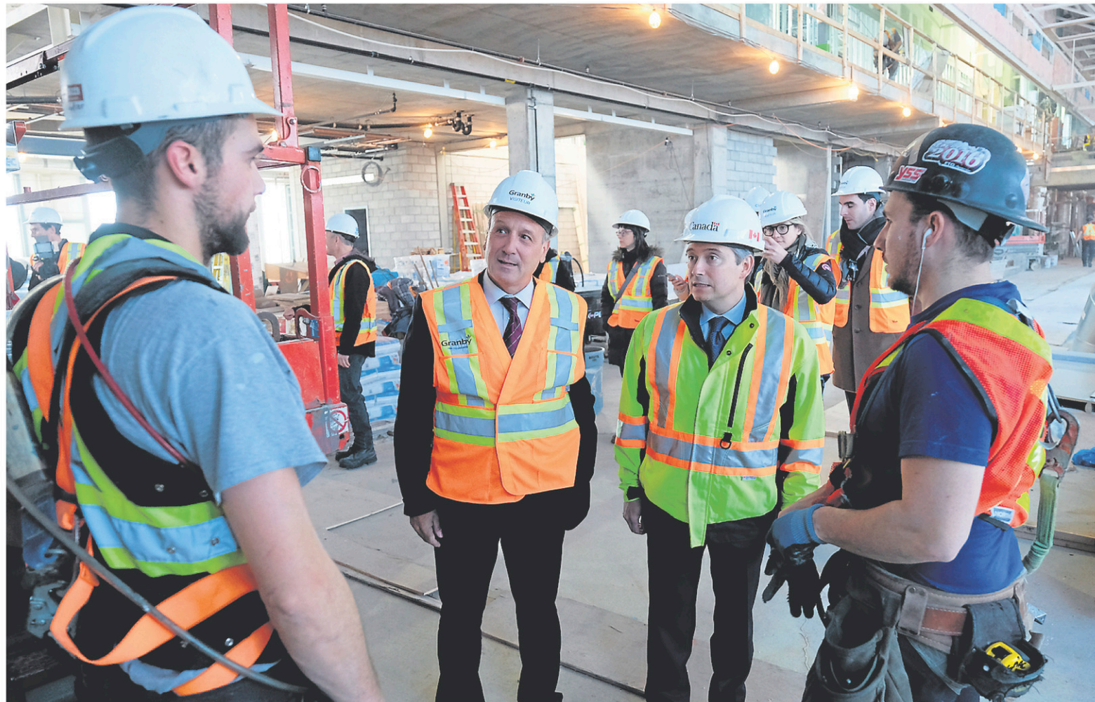
Le ministre fédéral de l'Infrastructure et des Collectivités, François-Philippe Champagne, a visité le chantier du centre aquatique de Granby lundi. — PHOTOS ALAINDION
