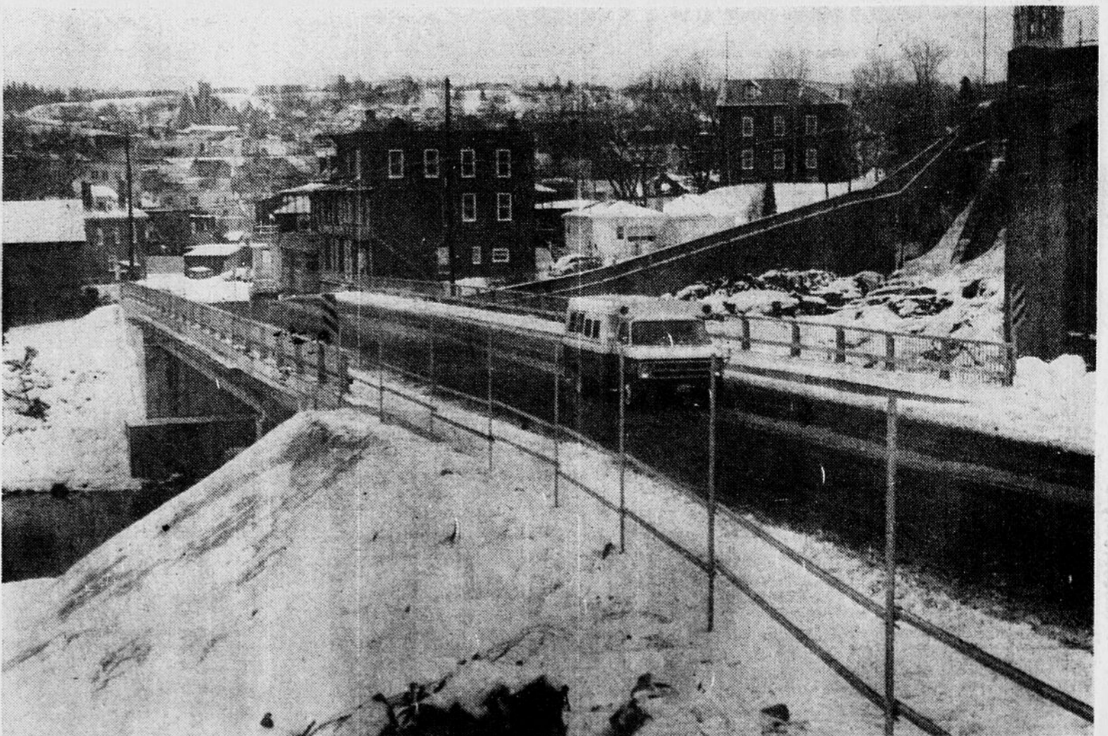
PONT PRICE — Après plusieurs mois d'attente, de tergiversations, de controverses, le "cas" du pont Price, sur la rue du même nom à Chicoutimi, est maintenant réglé. Le pont n'a pas encore été
