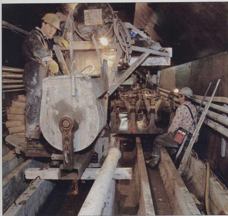
À l'aide d'une machine spécialement conçue pour installer ces structures, les six câbles sous-fluviaux seront déposés dans deux rangées de caniveaux préfabriqués par sections.
