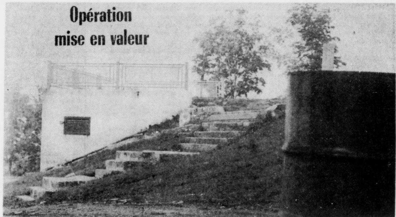
Tout près de la croix lumineuse.
