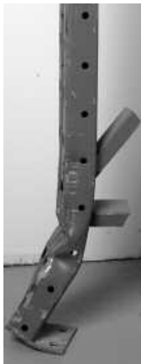
Figure 51b. Même montant endommagé (Vue de côté)
