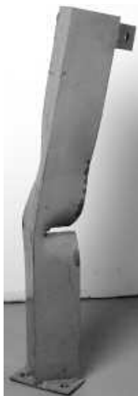
Figure 56. Protecteur de montant endommagé (Photo : Maurice Vézinét)
