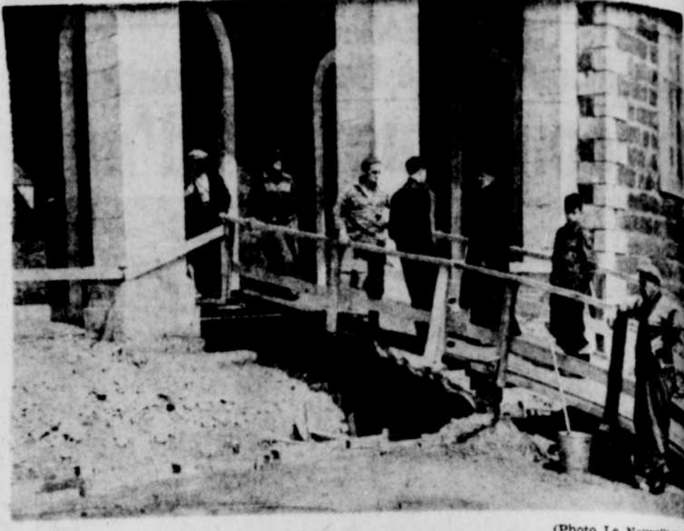
D'IMPORTANTES travaux sont présentement effectués à l'entrée de l'église de Champlain. On voit M. le curé Josphat Baril qui s'entretient avec un groupe d'ouvriers.
