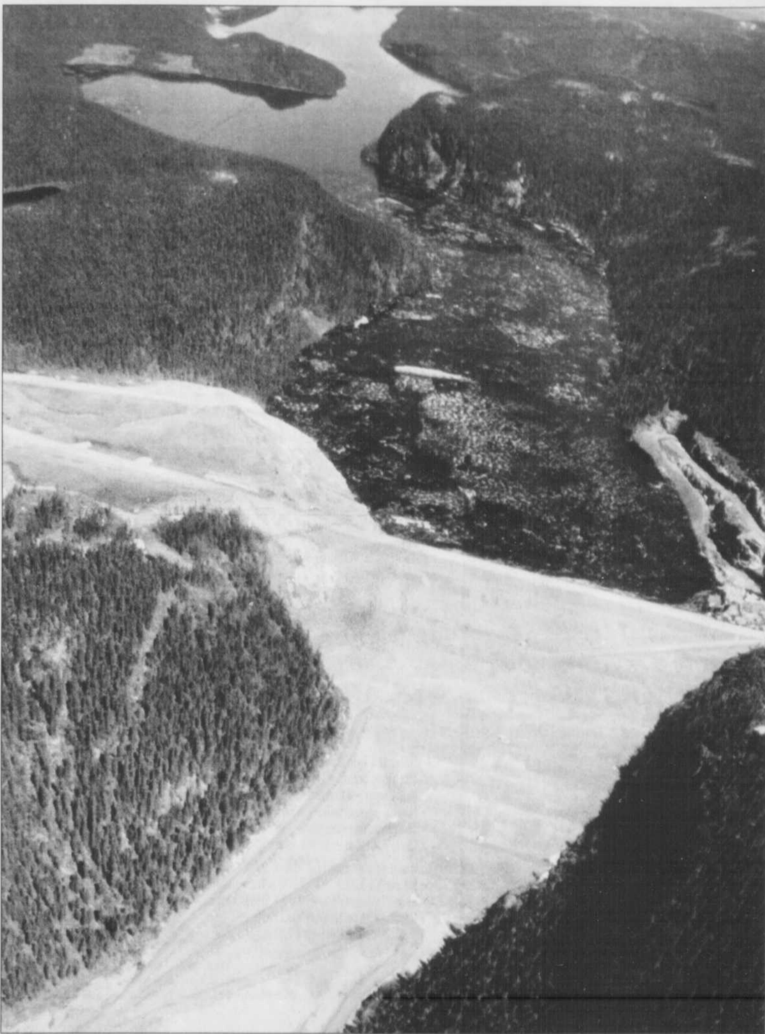
Le barrage hydroélectrique SM3 sur la rivière Sainte-Marguerite.
