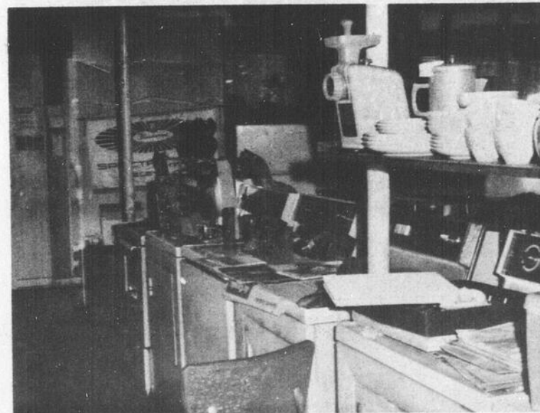
Une épaisse couche de suie recouvre les nombreuses pièces de vente exhibées au rez-de-chaussé de l'établissement. Même si les flammes ne s'y sont pas propagées, les dommages causés ici s'avèrent fort importants.
