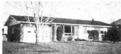
213 Campagna, Arthabaska. 6 pièces. Air chaud. Sous-sol fini. Garage. Piscine creusée.
