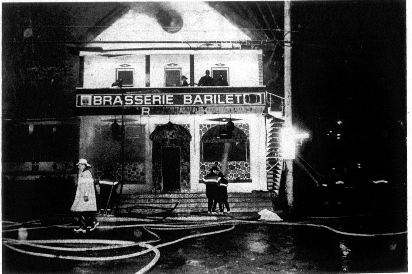
Un important incendie a détruit la Brasserie Barilet et une résidence privée au cours du mois de mai.
