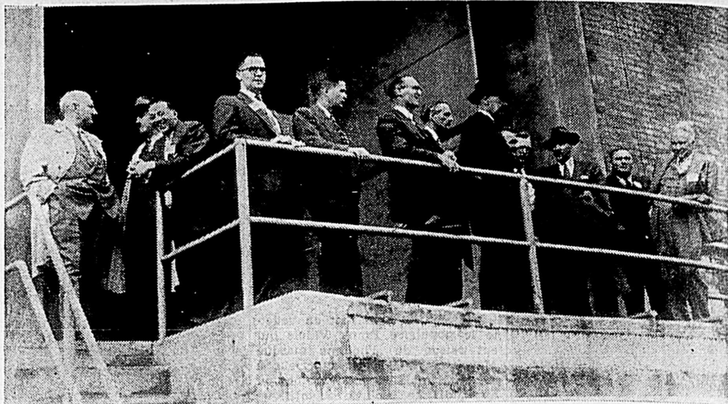
QUELQUES MEMBRES DU BOARD OF TRADE DE MONTREAL A L'USINE DE POUVOIR No 3.—Lors de la visite du Board of Trade de Montréal dans notre ville la semaine dernière, quelques-uns des visiteurs se sont rendu visiter l'usine de pouvoir No 3 de la Shawinigan Water and Power Co. On distingue ici, de g. à d.: Messieurs Gordon Hulme, (S.W.&P. Co.), F. E. Weldon,
