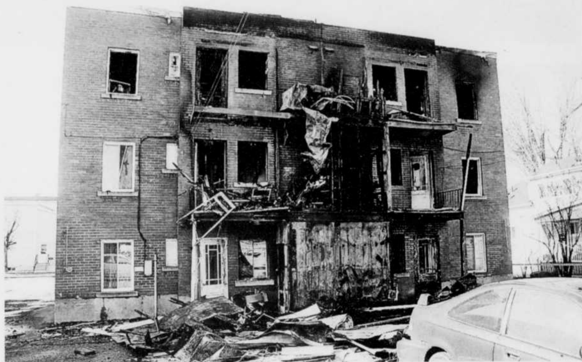
L'incendie dans un immeuble à logements de la rue Saint-Jean avait jeté à la rue plusieurs familles, en mars 2010, en plus de causer pour près de 500 000 $ de dommages.
