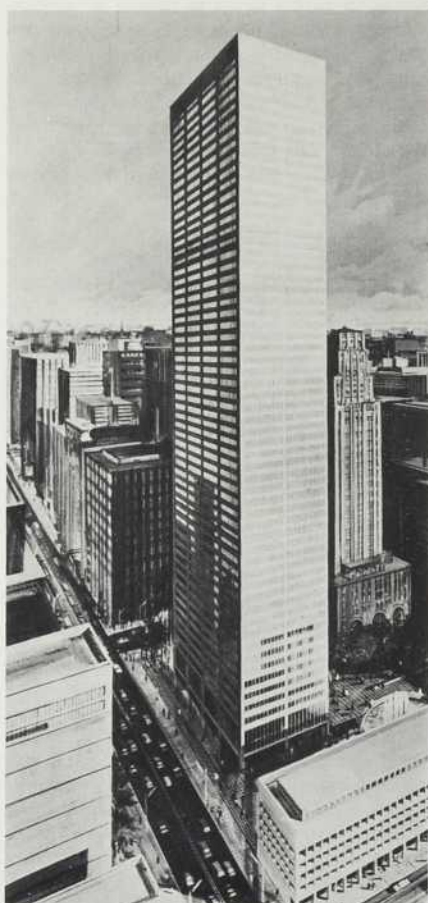
Cuirasse d'acier inoxydable, fenêtres à double-vitres miroir... l'ensemble; l'étrénelant "Commerce Court".
