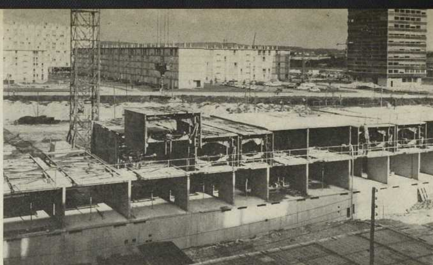
Coffrages tunnels Tracoba IV.
