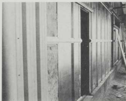
De l'acier partout: toiture, ancrages, huisseries, habitacles, conduits d'air. En bas: Panneaux d'acier prépeints sur tous les murs de l'étage de service.
