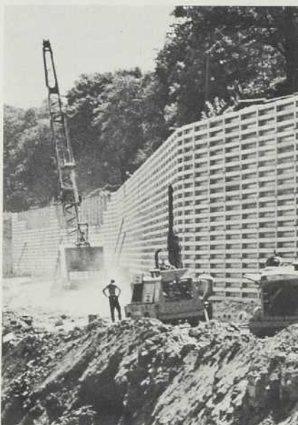
La nouvelle voie d'accès Claremont de Hamilton, taillée à même le roc, ne fut possible que grâce aux 100,000 pieds carrés de soutènement, couvrant le flanc rocheux instable.
