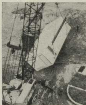
La grue géante, avant de commencer l'opération de soulèvement, redresse l'unité.
