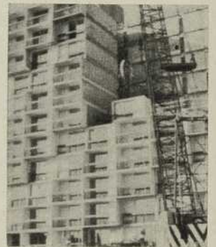
La motion de l'unité dans sa position normale requiert l'excellente coordination d'équipe entre le mécanicien de la grue et les monteurs "sur la plateforme".
