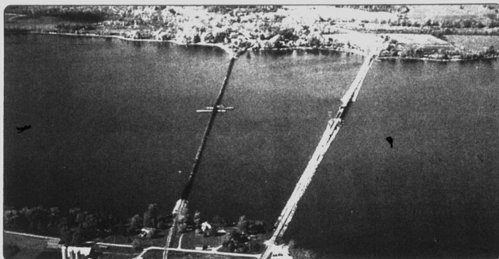
Le pont forme actuellement une barrière qui entrave l'écoulement naturel de l'eau.
