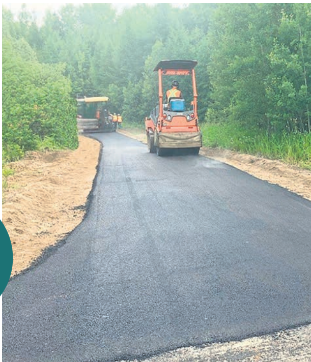
La réalisation de travaux dans le cadre du projet de Véloroute.
