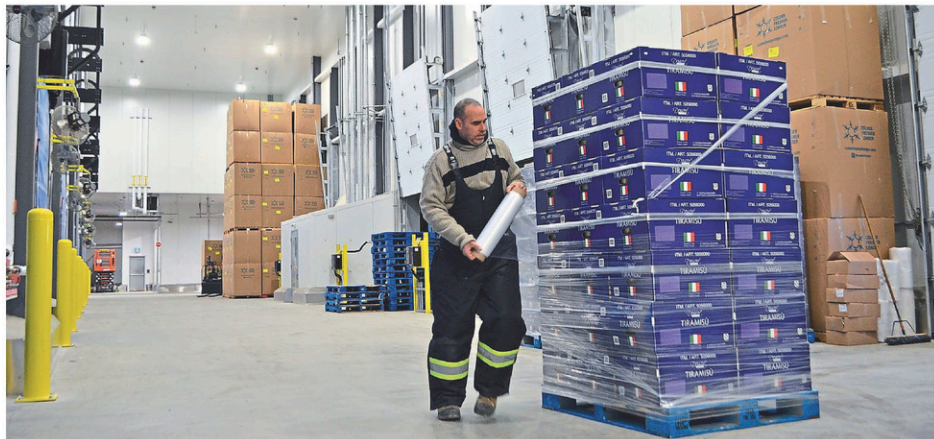
L'Entrepôt congelé alimentaire 10-48 peut accueillir 8000 palettes de marchandise. Il offre également un service de préparation de commandes pour fins d'expédition.
