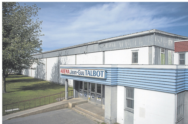
L'aréna Jean-Guy-Talbot devait bientôt être démolie. Le retard dans les travaux au nouveau Colisée modifiera-t-il les plans? — PHOTO: FRANÇOIS GERVAIS
