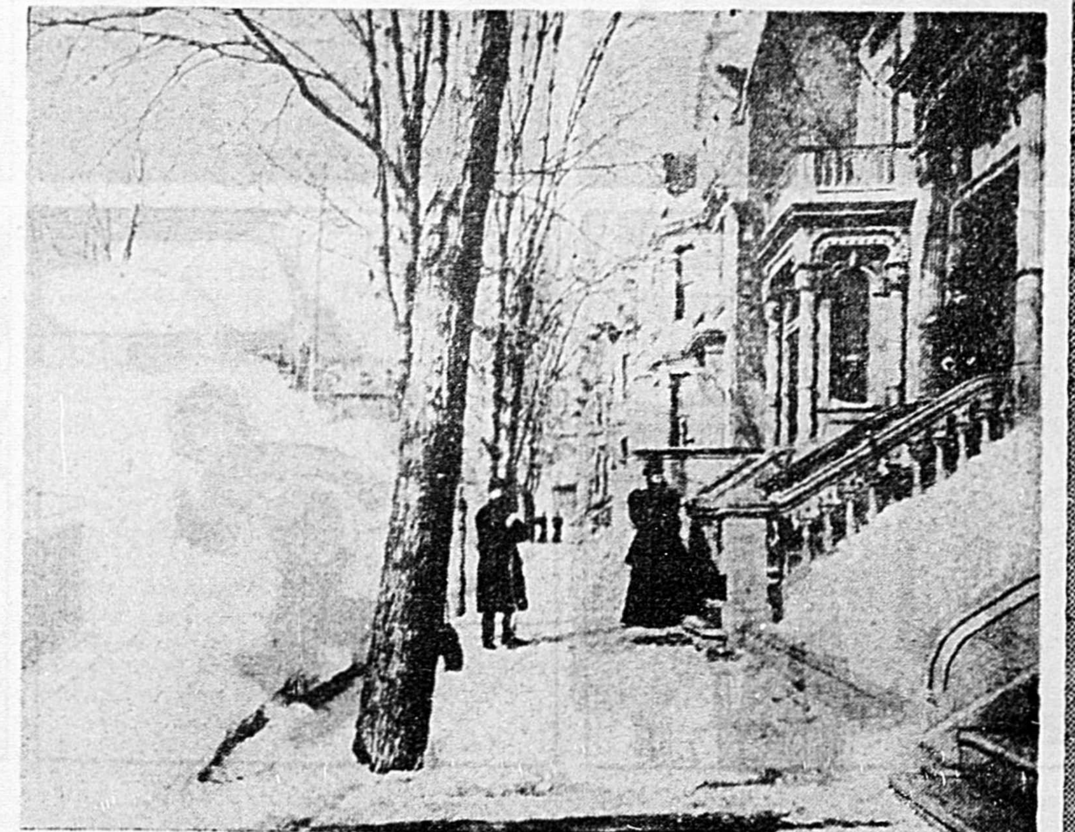
On déblayait les rues et trottoirs à la pelle. Banc de neige de 18 pieds, rue Peel, à Montréal.
