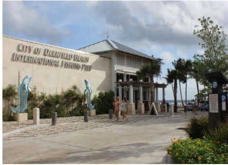
La reconstruction des bâtiments du complexe municipal s'est terminée en 2013.
