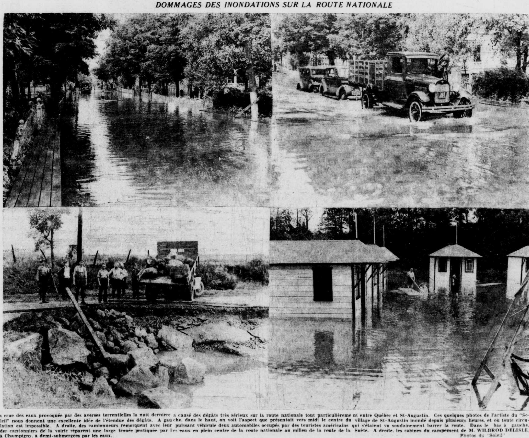
La crue des eaux provoquée par des averses torrentielles la nuit dernière a causé des dégâts très sérieux sur la route nationale tout particulièrement entre Québec et St-Augustin. Ces quelques photos de l'artiste du "Soleil" nous donnent une excellente idée de l'étendue des dégâts. A gauche, dans le haut, on voit l'aspect que présentait vers midi le centre du village de St-Augustin inondé depuis plusieurs heures, et où toute circulation est impossible. A droite, des camionneurs remorquant avec leur puissant véhicule deux automobiles occupés par des touristes américains qui s'étaient vu soudainement barrer la route. Dans le bas à gauche, des cantonniers de la voirie réparent une large trouée pratiquée par les eaux en plein centre de la route nationale au milieu de la route de la Suète. A droite, les cabines du campement de M. WILBROD DELISLE à Champigny, à demi-submergées par les eaux.
