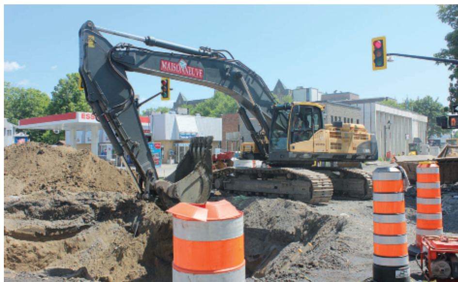
Photo Mychel Lapointe - Archives Des travaux d'envergure débutent sur la rue du Palais.
