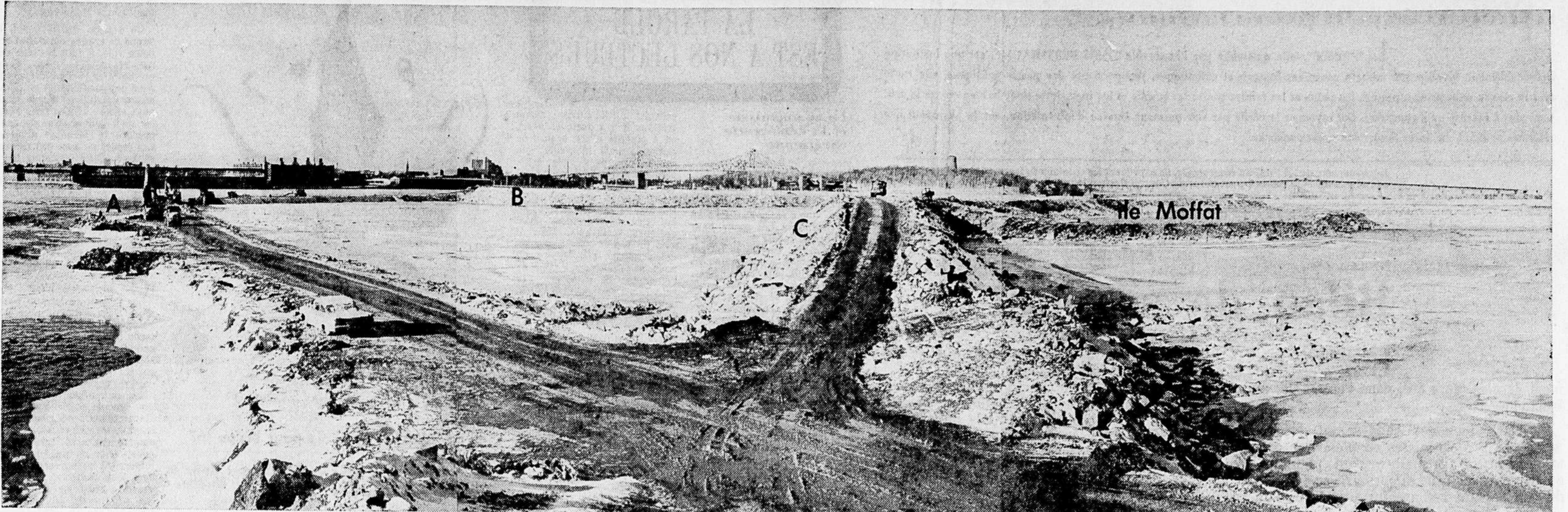
A L'ILE NOTRE-DAME, on travaille jour et nuit à la démolition du batardeau (A) de 1.440 pieds coupant le Saint-Laurent entre l'île Moffat et l'île Verte. Quatre
