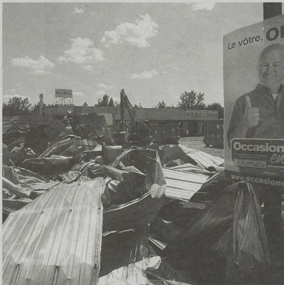
Baril Ford Lincoln investit 1,1 M$ pour l'agrandissement de ses structures du boulevard Laurier. Photo Robert Gosselin | Le Courrier ©
