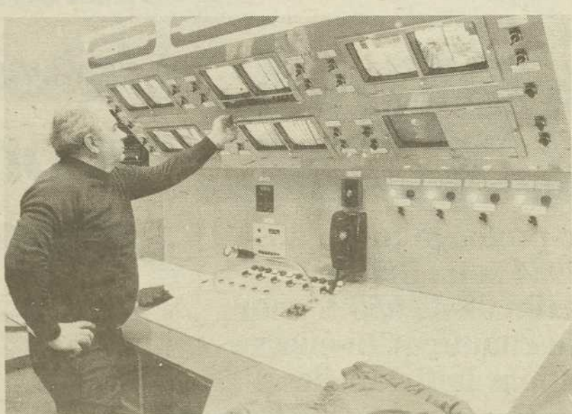
Les modifications de la console de la caserne ont été apportées seulement après que celle-ci a été totalement construite.
