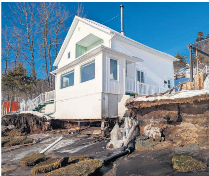
Certaines résidences, plus près de la plage, ont été davantage touchées comme celle-ci qui a perdu sa fosse septique. Photo courtoisie
