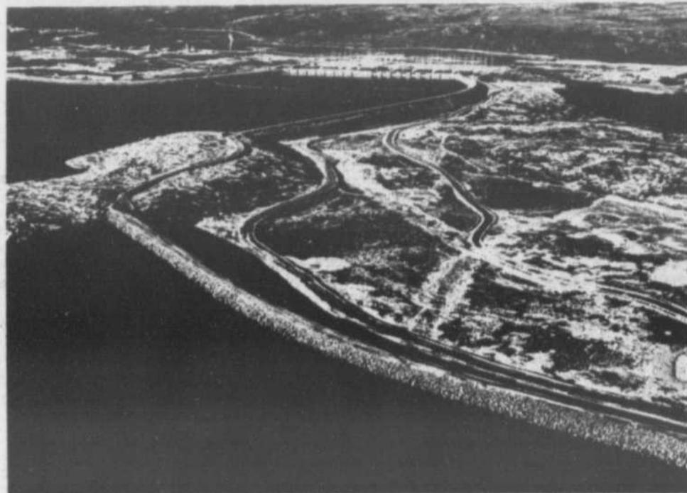
LE BARRAGE, UNE DIGUE ET LA PRISE D'EAU.
