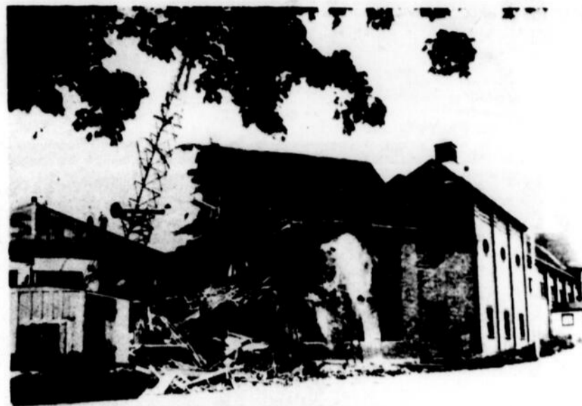
Le pic des démolisseurs abat le vieux centre récréatif.
