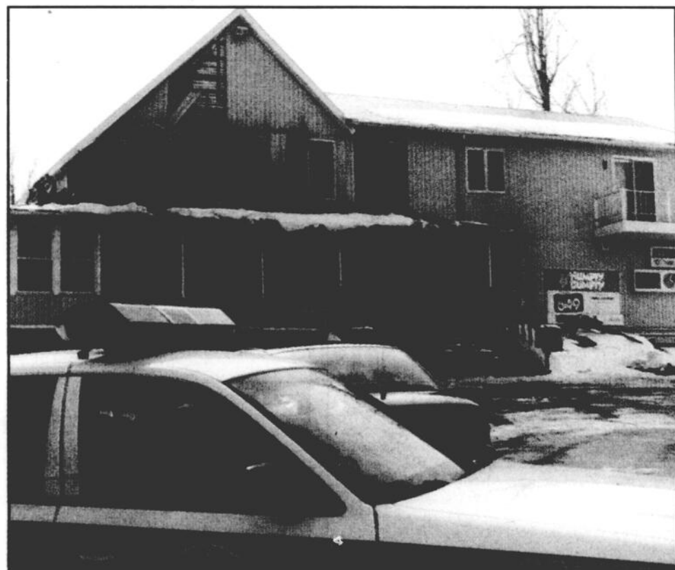
Un incendie a causé des dommages considérables tôt vendredi matin au dépanneur Accomodation Franklin Centre, situé en bordure de la route 202. Le feu s'est attaqué au sous-sol servant d'unité de rangement et à une bonne partie de l'édifice avant que les pompiers de l'Entraide mutuelle ne parviennent à l'éteindre. (photo P.L.) (J.T. trad. P.L.)
