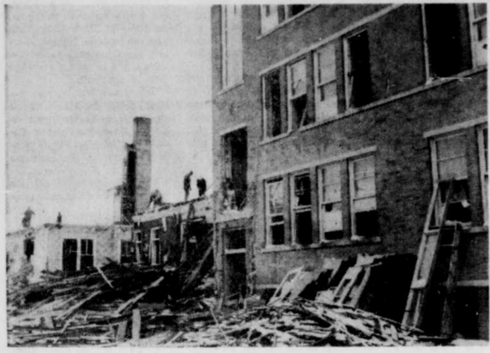
La démolition du Collège St-Aimé d'Asbestos va bon train et d'ici quelques jours une foule de souvenirs se seront envolés avec la bâtisse.
