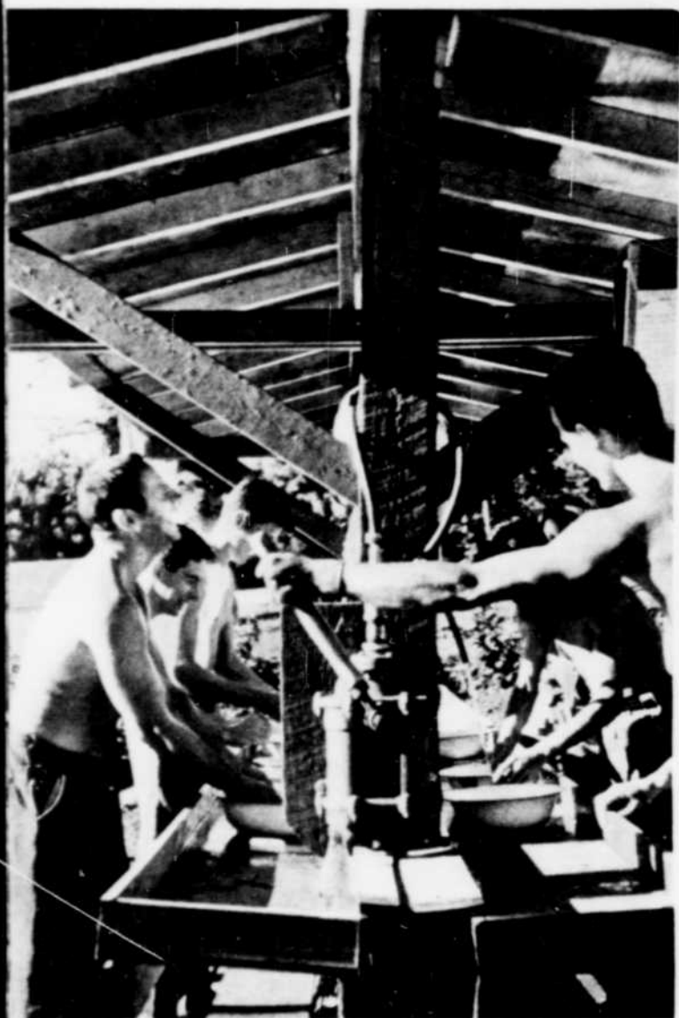
Après le travail, c'est à un lavabo installé en plein air que les étudiants doivent faire toilette, en pompant gaillardement l'eau à tour de rôle.
