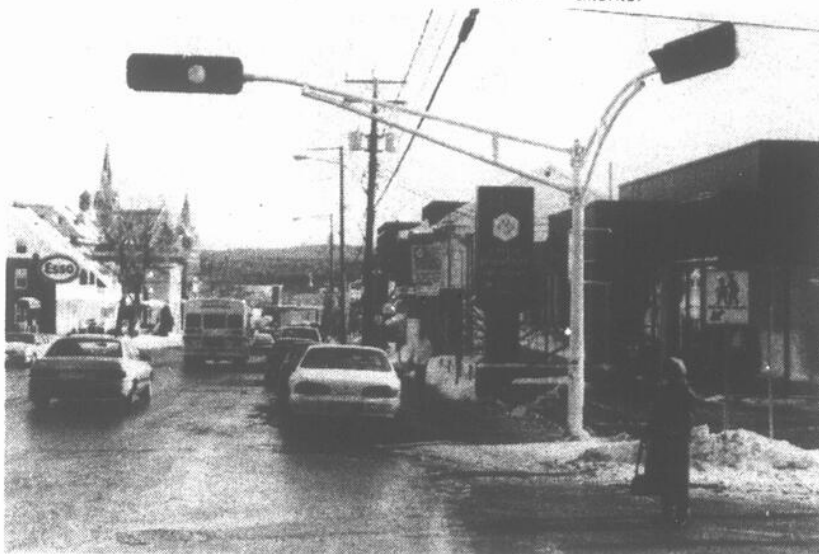
Le nouvel aménagement à l'intersection des rues Laval et Maisonneuve amène certains changements au niveau de la circulation automobile et piétonnière.
