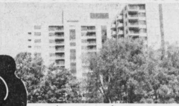
Condominium de Bernières 10, avenue de Bernières Québec
