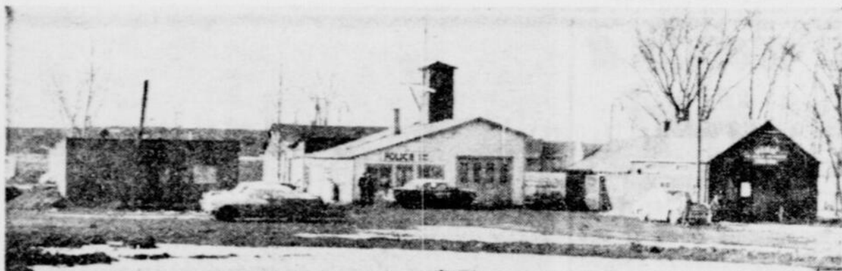
LA CANALISATION BALAYE LE CENTRE ADMINISTRATIF DE MONTREAL-SUD — La mairie, ancienne gare de la traverse de Longueuil, le hangar de la police et la cabane de pompiers devront disparaître, car le terrain appartient aux Havres Nationaux. Les travaux d'approche du pont Jacques-Cartier avancent rapidement. Les propriétaires ayant refusé le règlement proposant l'acquisition d'une résidence pour en faire un hôtel-de-ville, la Cité devra louer un local pour son administration.
