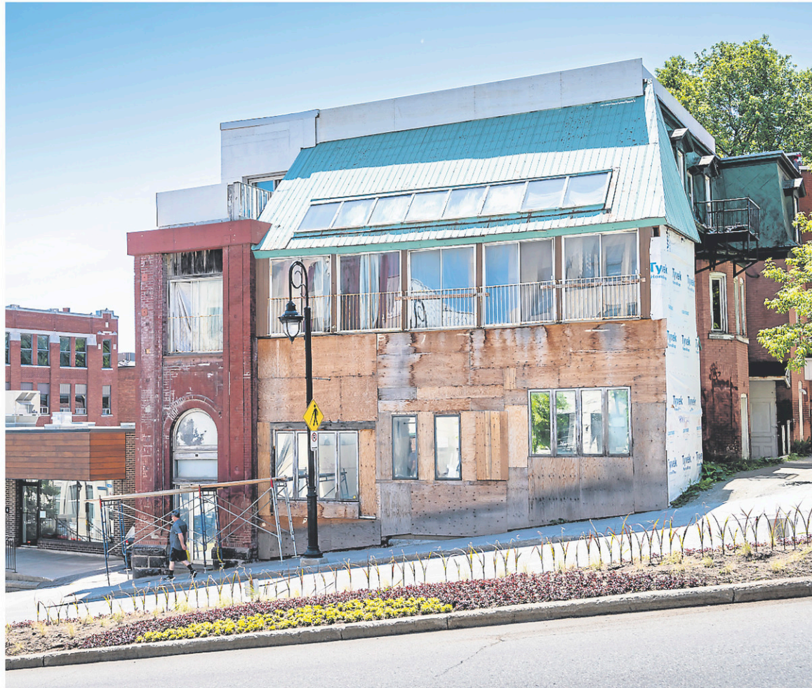
La Ville de Sherbrooke souhaite que le propriétaire de cet immeuble réalise des travaux de réfection et lui impose des constats d'infraction pour le forcer à réagir. — PHOTO ARCHIVES LA TRIBUNE, JESSICA GARNEAU
