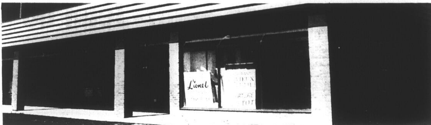
Rue Normand, dans l'édifice de Servico qui longe le boulevard du Séminaire dans le quartier Nord de Saint-Jean, c'est en novembre que le réseau Au Vieux Duluth ouvrira un 11e restaurant à Saint-Jean. (photo guy LE SIEUR)
