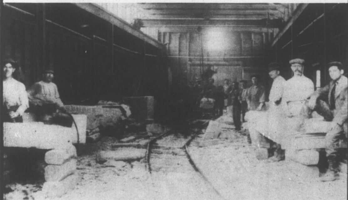
Cette photo qui date du début des années '30 nous fait découvrir une vue intérieure de l'usine de la "Silver Granite" (aujourd'hui Frontenac Granite). À remarquer les systèmes utilisés pour le transport de la pierre, soit le rail et le levier-roulant. Toute personne pouvant fournir des renseignements sur cette photo ou identifier des personnages est priée de communiquer avec Michel Fortin au 652-2320. Cette photo a été prêtée par Mme Danielle Gosselin.
