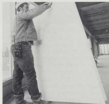
La façade du magasin Eaton sera revêtue d'acier émaillé. Ce matériau a été choisi pour des raisons économiques et esthétiques.
