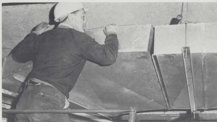
Installation d'un conduit d'air en acier galvanisé sur le chantier de la Banque Royale, à Toronto. La fabrication des conduits est entièrement automatisée.
