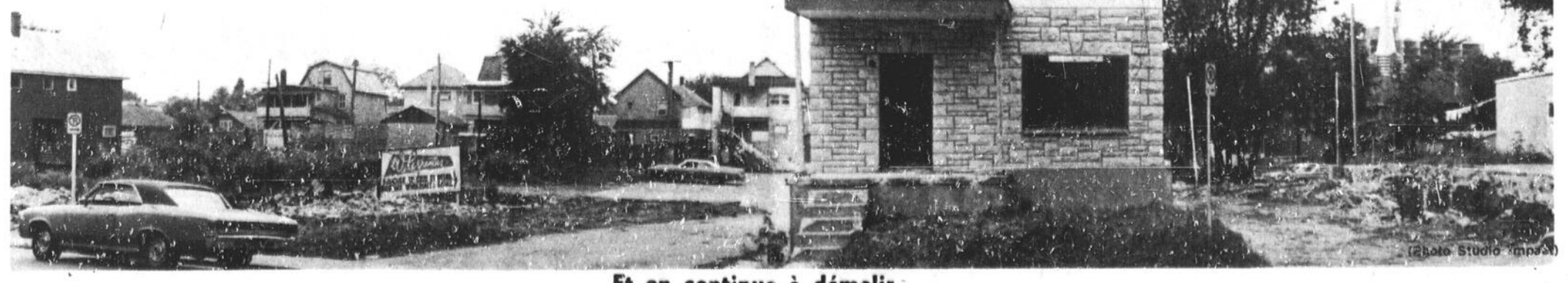
Et on continue à démolir...
