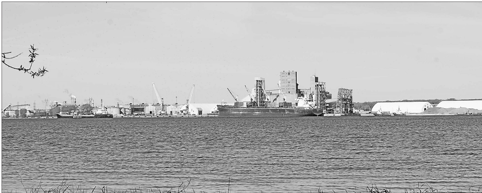
Les travaux de modernisation du port de Trois-Rivières figurent sur la liste des bons coups relevés par le Conference Board du Canada. — PHOTO: SYLVAIN MAYER
