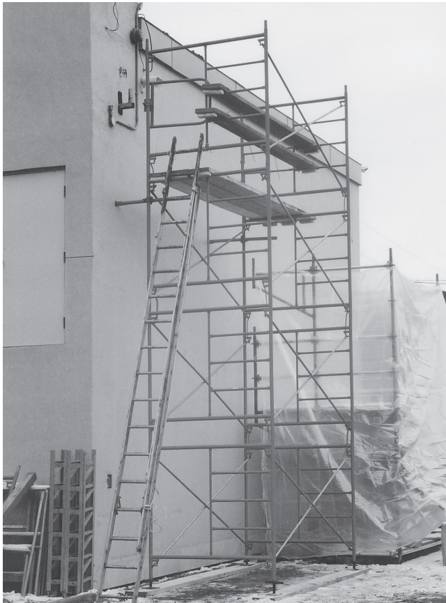
Échafaudage sur cadres métalliques traditionnels
