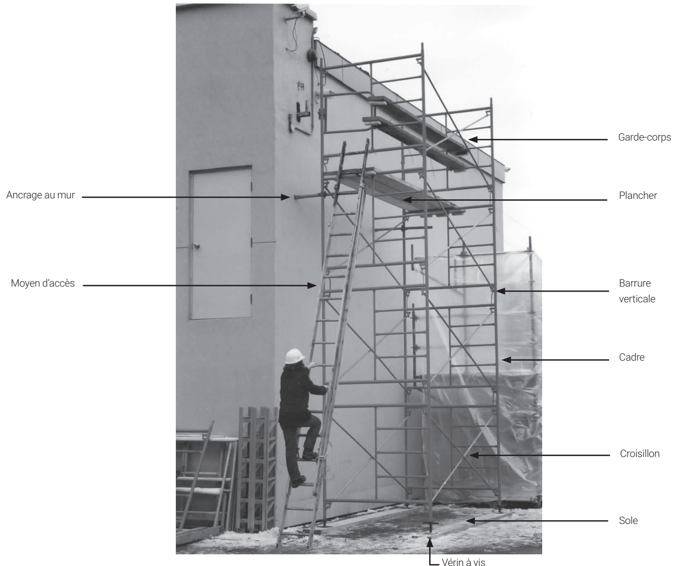
Composants des échafaudages sur cadres métalliques
