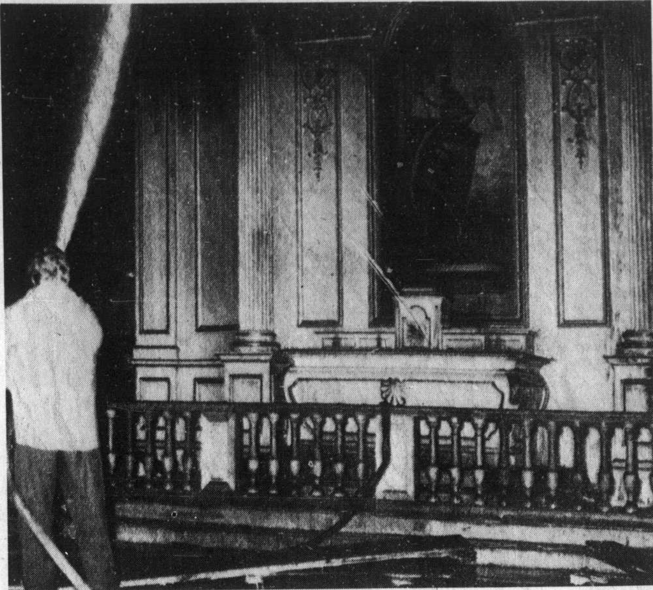
Une partie de la forteresse de Louisbourg, restaurée à coût fort depuis 1961, a été endommagée par les flammes et la fumée dans la nuit de mardi à hier. Une enquête est en cours pour évaluer les dégâts, surtout dans la chapelle et dans une partie de l'aile dite des gouverneurs. C'est un gardien de nuit qui a donné l'alerte peu après avoir découvert de la fumée à proximité du "bastion du Roy". Réputée imprenable par les Français, la forteresse, construite entre 1720 et 1745, avait ultérieurement été démolie par les soldats britanniques. On croit que nombre de maisons du Cap-Breton ont été érigées avec des pierres provenant de la forteresse démolie, que le gouvernement canadien décidait de restaurer dans les années 60. (Téléphoto CP)
