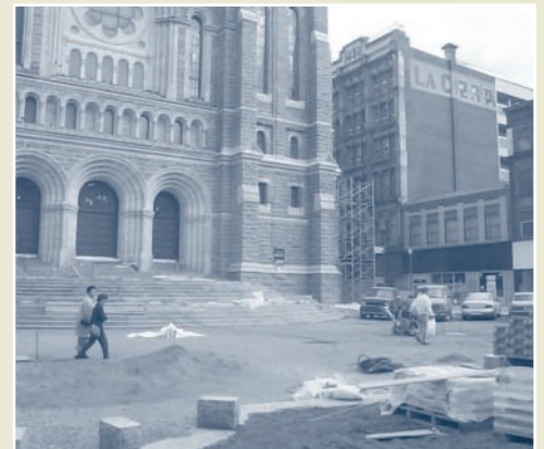
Réfection du parvis de l'église de Saint-Roch.
