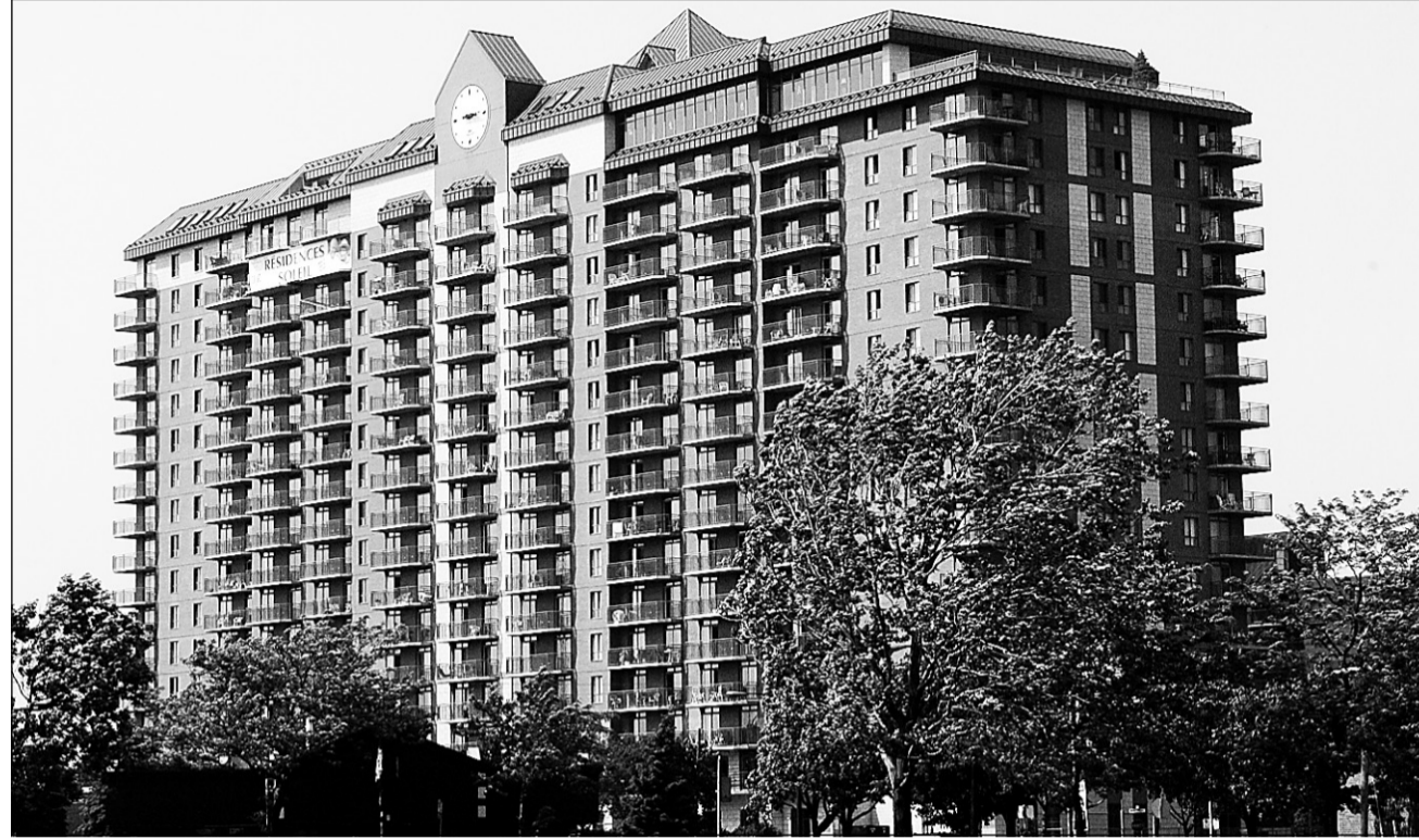
Les travaux s'achèvent au Manoir Saint-Léonard, qui comprend 621 appartements. C'est la plus grande résidence pour personnes âgées construite au Canada d'un seul trait, selon Nataly Savoie, vice-présidente au marketing des 10 résidences soleil du Groupe Savoie.
